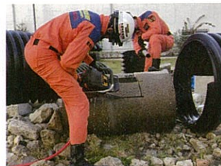
コンクリートを切断できるチェーンソーの取り扱い訓練
